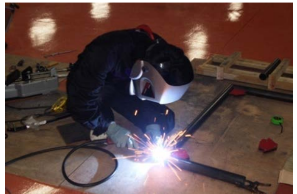
③溶接作業
