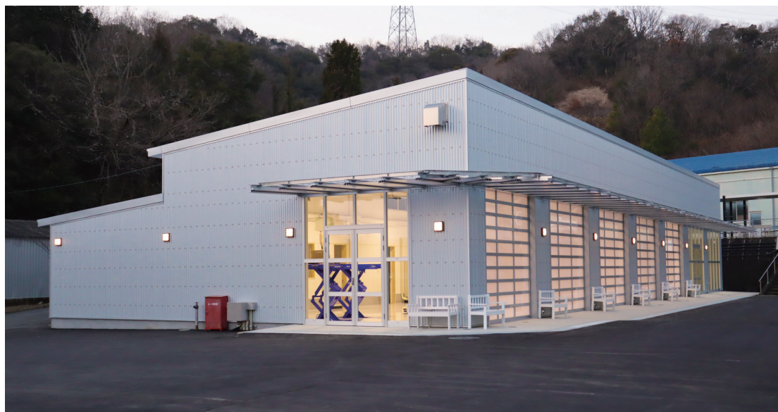
新実習棟 6号館
